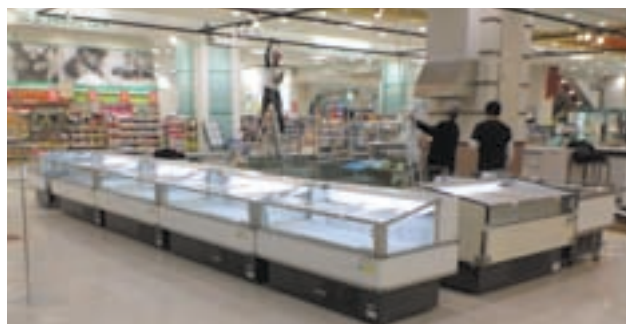
現場施工風景
